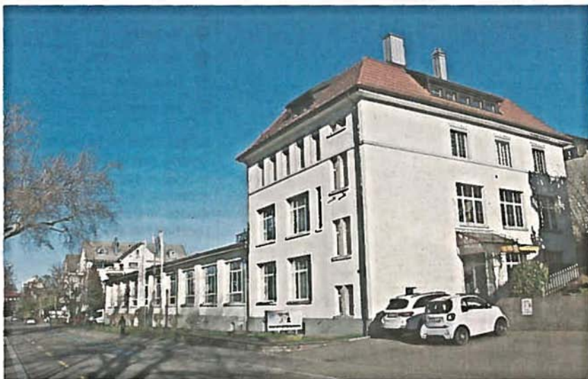
Die Fahnenfabrik an der Lindenstrasse wird umgebaut.
